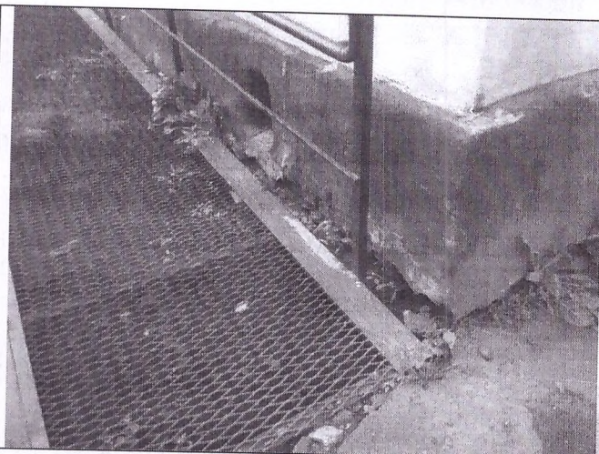
Фото 3,4. Отмостка здания имеет повреждения
