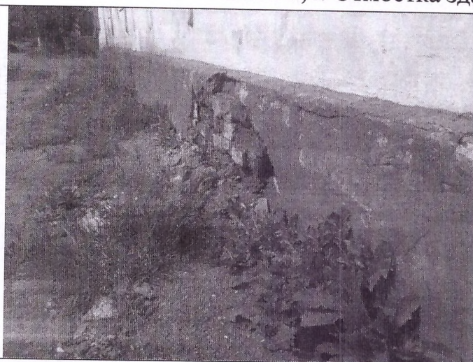
Фото 5,6. Повреждения штукатурного слоя в цокольной зоне, оголение кирпичной кладки. Наличие растительного слоя на отмостке.
