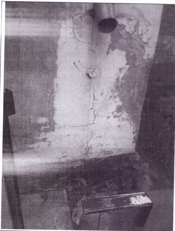
Фото 9,10. Повреждения штукатурного слоя в цокольной зоне, оголение кирпичной кладки. Деструкция штукатурного слоя поверхности стен.
