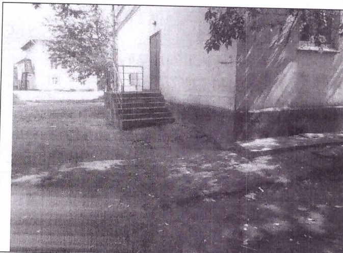
Фото 3,4. Отмостка здания имеет повреждения
