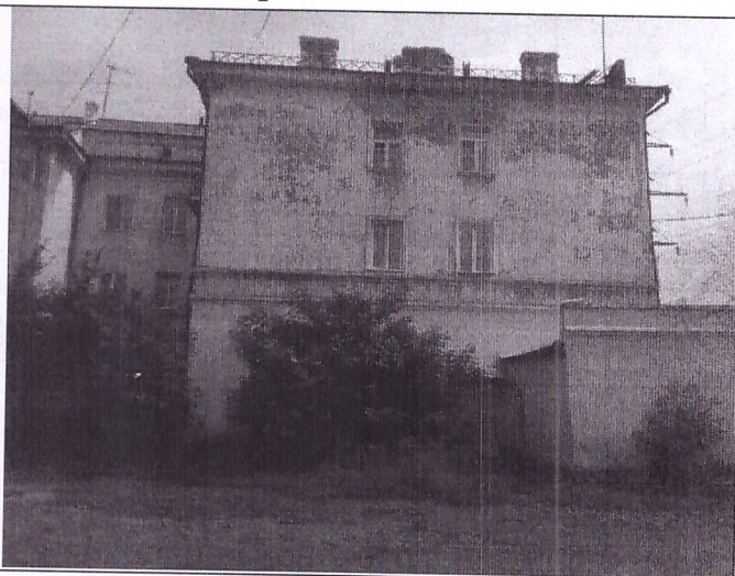
Фото 11,12. Повреждения штукатурного слоя в зоне карниза. Нарушения окрасочного слоя.
