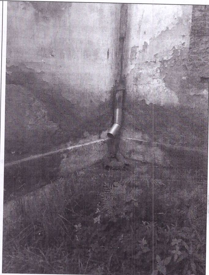
Фото 9,10. Повреждения штукатурного слоя в цокольной зоне, оголение кирпичной кладки. Деструкция штукатурного слоя поверхности стен.
