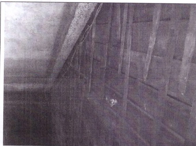
Фото 13. Подвальное помещение. Косоуры лестницы в подвал повреждены поверхностной коррозией.
