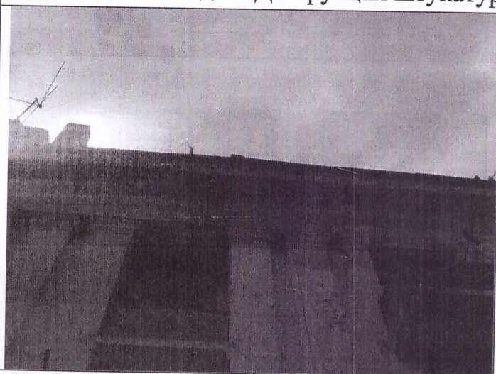
Фото 11,12. Повреждения штукатурного слоя в зоне карниза. Нарушения окрасочного слоя.
